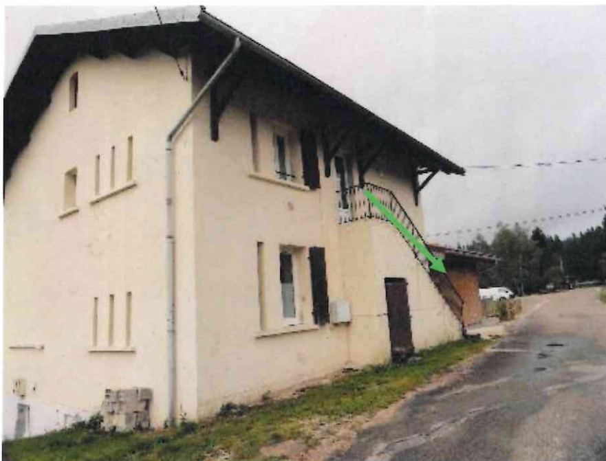
Escalier de secours R+1 (locaux à sommeil)
