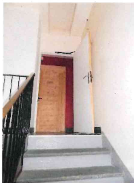
Porte coupe-feu avec Ferme- au R+1 dans l'escalier
