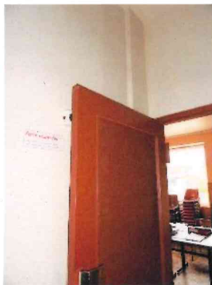
Escalier encloisonnés porte Desservant RDC au R+1
